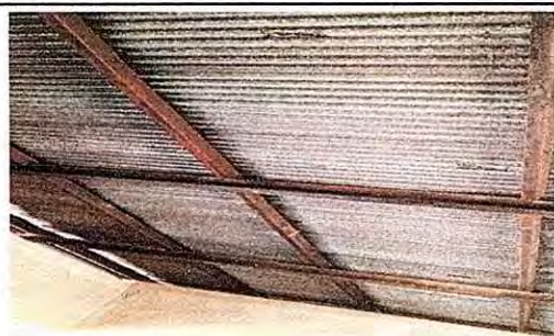
Foto 3: Sustitución estructura de techo
