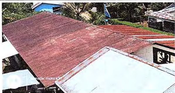
Foto 7: Sustitución de canales
