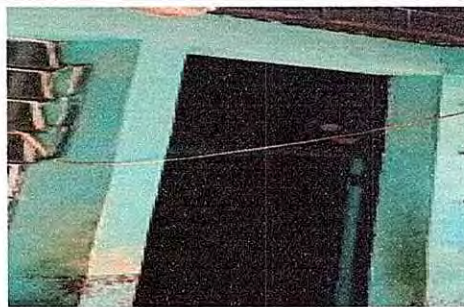
Foto 10: Sustitución de pintura
