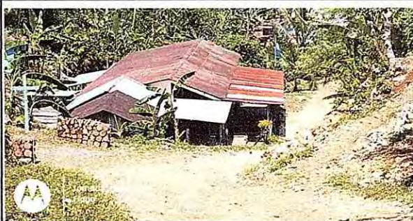
Foto 2. Sustitución de cubiertos de láminas
