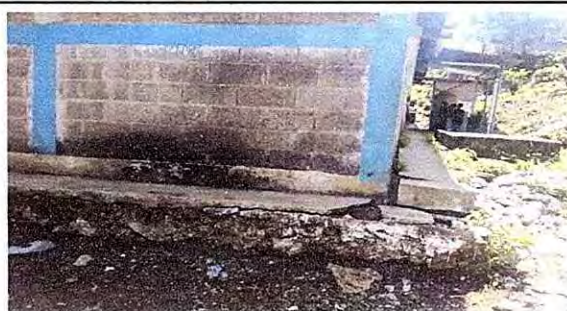
Foto 12: Sustitución de losa de patio
