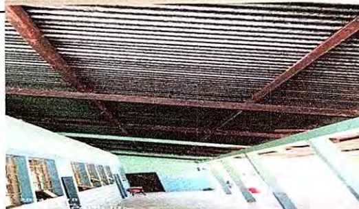
Foto 4: Sustitución estructura de techo
