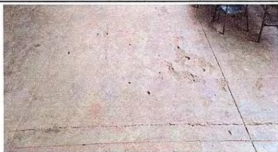
Foto 11: Sustitución de pisos
