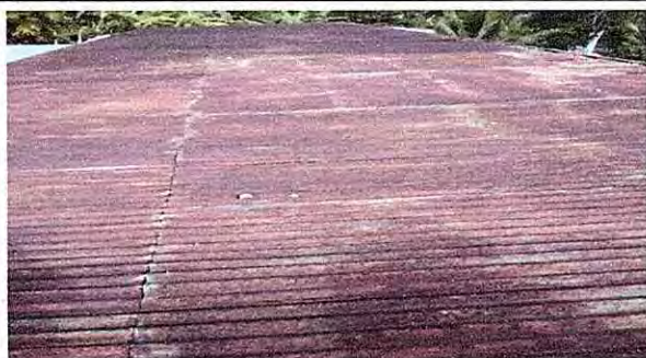
Foto 1. Sustitución de cubiertos de laminas
